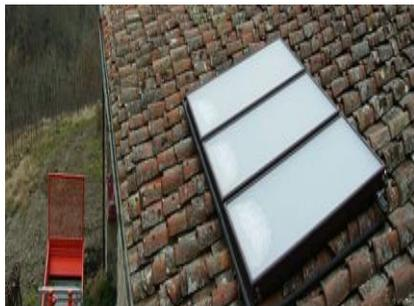
Impianto per la produzione di acqua calda
